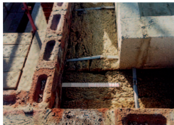
■ Isolation des murs extérieurs (© Biorégional, BedZED)
